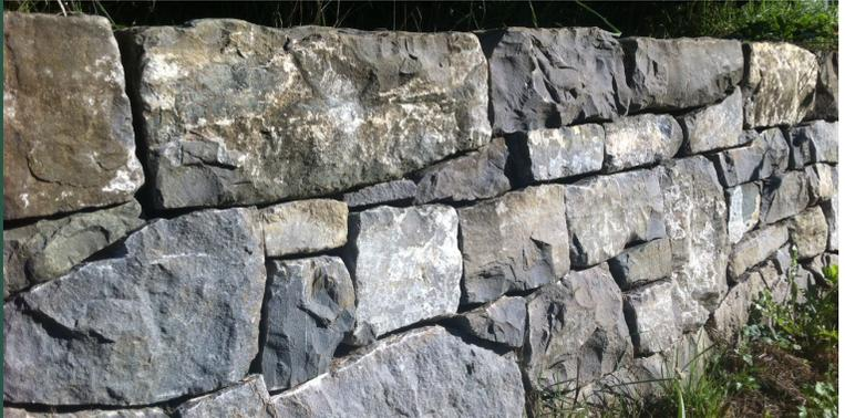
Der Bau von Trockensteinmauern ist eine jahrhundertealte traditionsreiche Bautechnik, bei welcher die bearbeiteten Steine ohne Beton oder sonstige Bindemittel Schicht für Schicht zu einer selbsttragenden Mauer aufgebaut werden.
